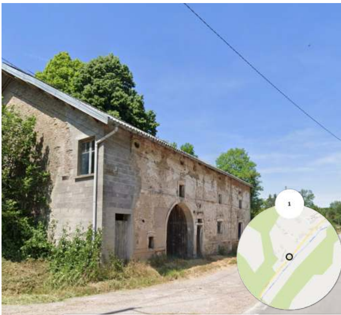
FAÇADE ET PIERRE GRAVÉE - 148 CHEMIN DES TRÉMOSEAUX
